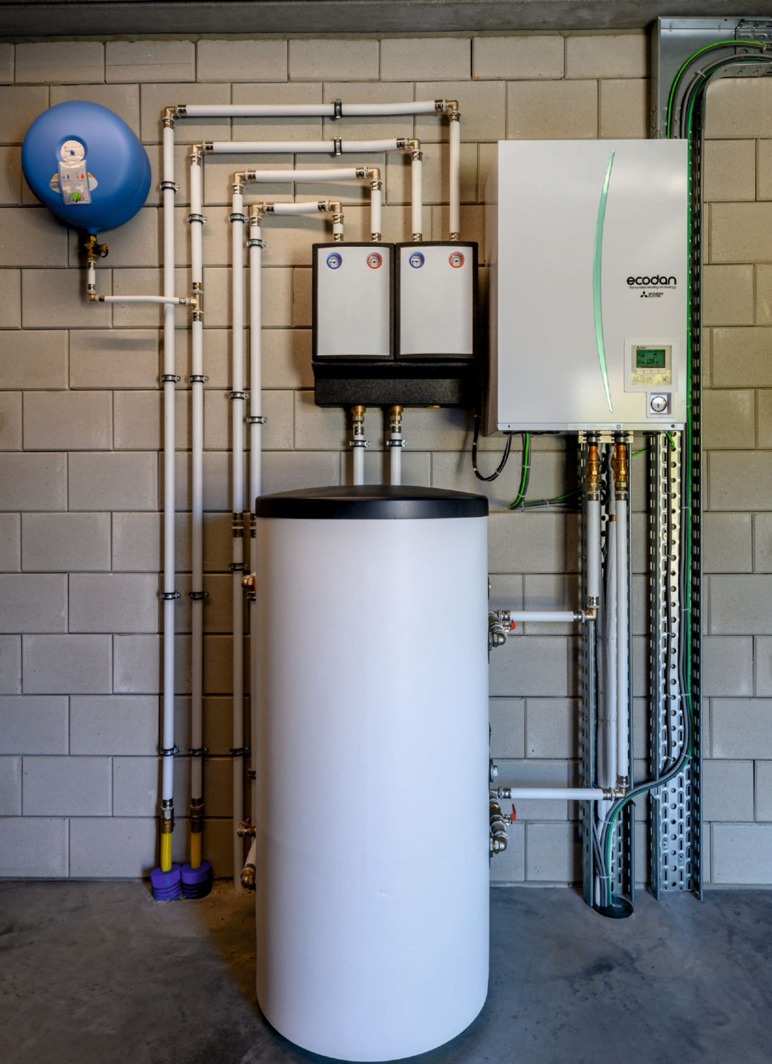
Nástěnný hydromodul s akumulací nádobou a řízením dvěma otopnými zónami
