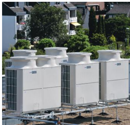
Integrovaná funkce zpětného získávání tepla v rámci technologie VRF R2 umožňuje ušetřit až 40 % energie.
